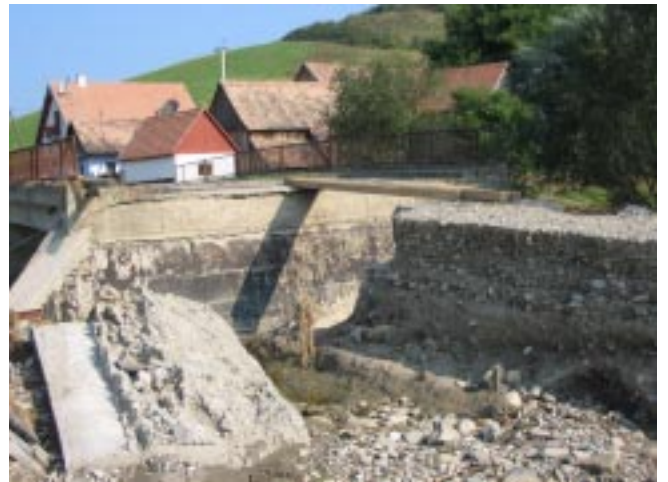
A Kobátfalvát Tarcsafalvával összekötő, járhatatlanná vált út és híd The road and the bridge linking Kobátfalva and Tarcsafalva have become uncrossable
