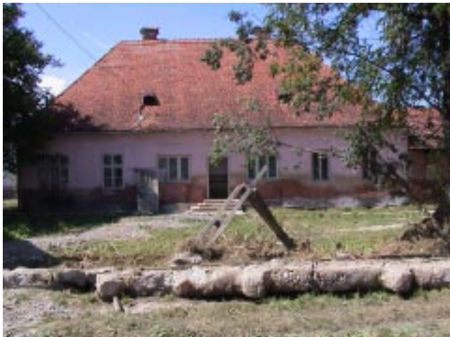
A kobátfalvi óvoda kívülről The outside view of the kindergarten in Kobátfalva
