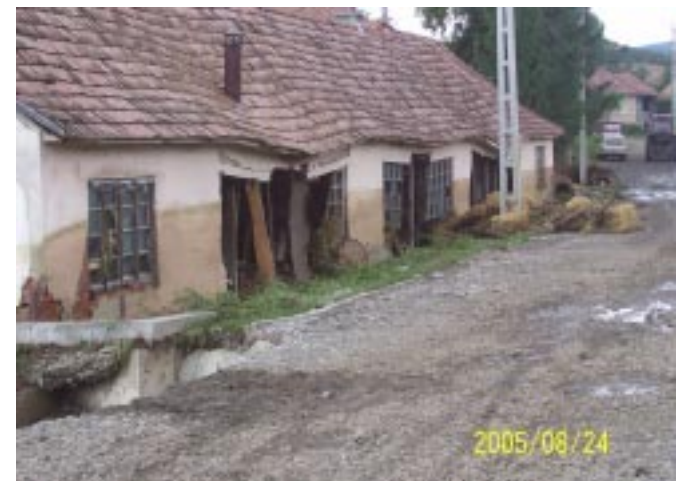
Beomlott oldalú kovácsműhely Siménfalván Blacksmith's workshop with ruined side in Siménfalva
